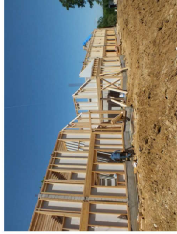
Montage des murs en ossature bois © DLA architectes
