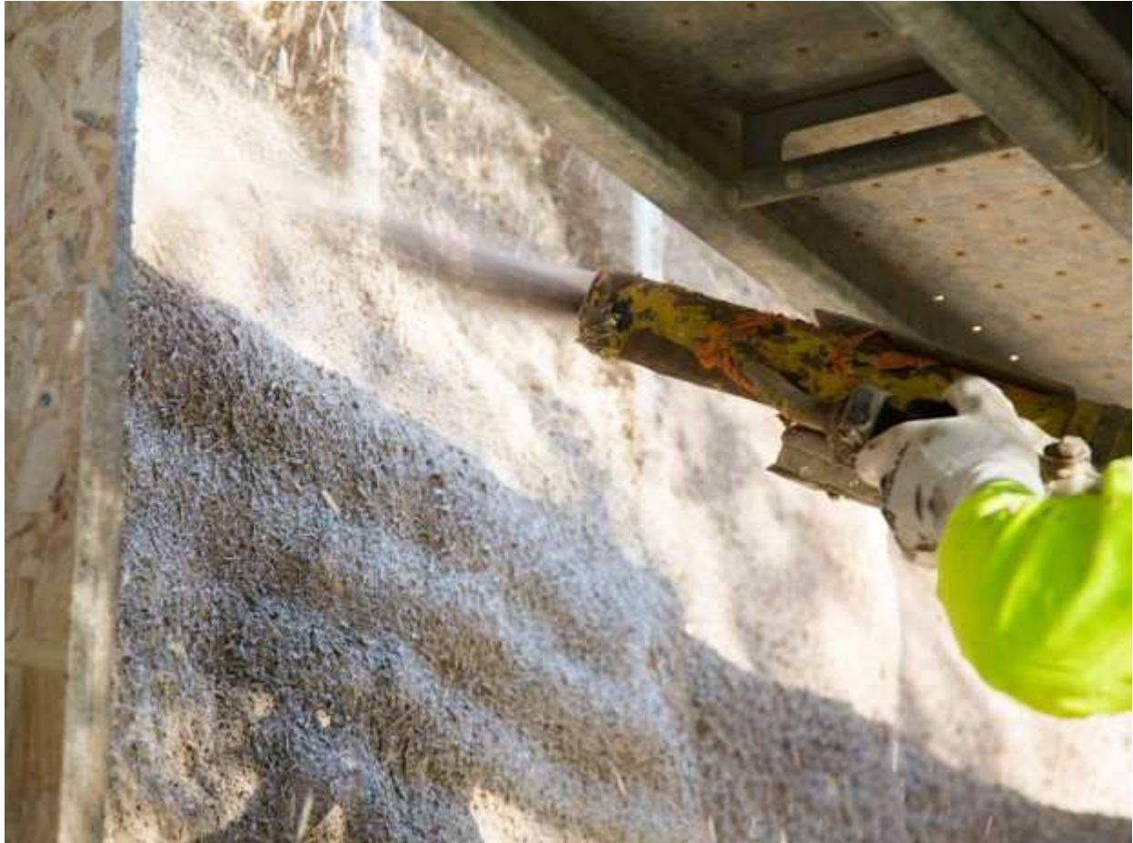
Béton de chanvre projeté © Vicat
