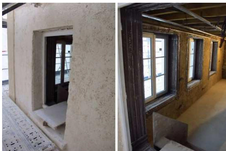
© Maya Pic - Côté extérieur, un enduit chaux-chanvre, et côté intérieur, 10 cm de béton de chanvre
